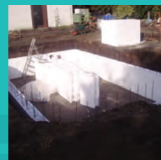
Vullen met beton
